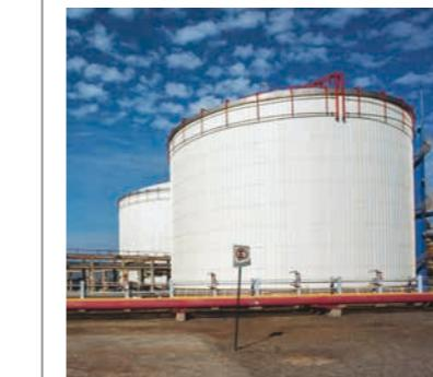
En 1998 entró en operaciones un tercer estanque, de 20 mil m<sup>3</sup>, generando una mayor eficiencia en los procesos logísticos. Este incremento en la capacidad de almacenamiento refrigerado, permitió recibir buques gaseros de 54 mil m<sup>3</sup>, creciendo las tasas de transferencia del terminal.
